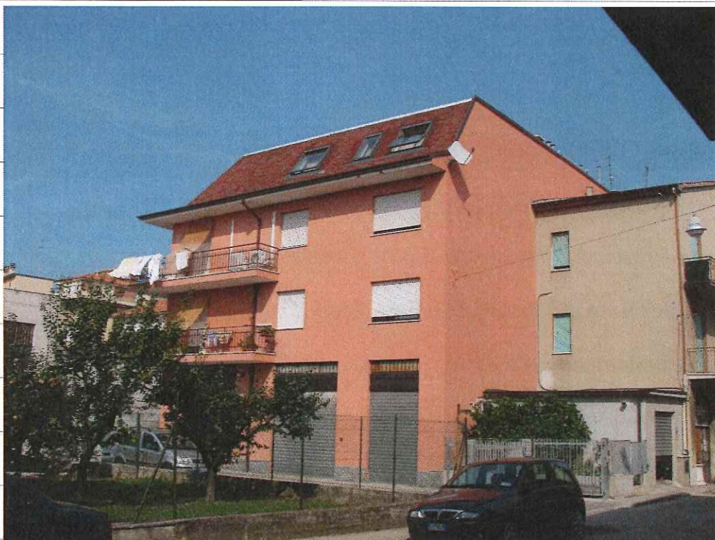
Vista sud dell'edificio (tre abbaini del locale uso appartamento)
